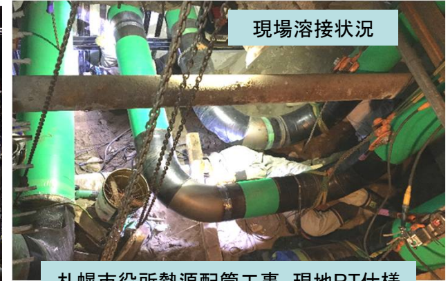
札幌市役所熱源配管工事 現地RT仕様
