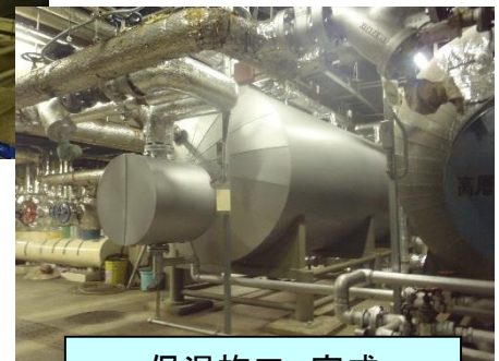
保温施工 完成
